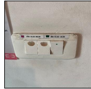
2.1-22 ควบคุมการปิด-เปิดไฟแสงสว่าง
